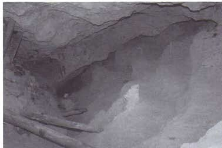
Fig.16 : Vue intérieure dans Carnic10-Inférieur au niveau des galeries G30 et G33 avec séries de galeries étagées visibles en section.
