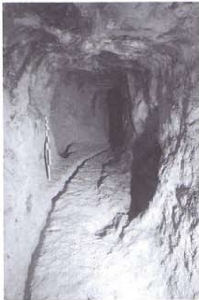
Fig.5 : La galerie G23 à la sole traversée par un canal d'exhaure dans Cârnic 1.
