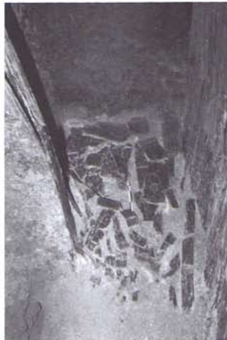
Fig.26 : Paru Carpeni. Les pièces de la roue hydraulique de la chambre C1 en cours de dégagement dans le fond du bassin. On notera le coffrage en planches du bassin encore en place contre les parois.
