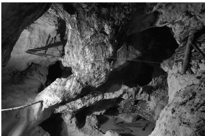
FIG. 3. — La grande chambre d'exploitation sur piliers C5 (8m de hauteur) du réseau Cărnici 1 vue dans sa partie médiane en fin de fouille (cliché B. Cauuet)
