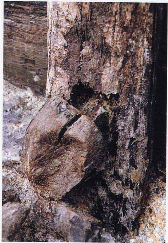
Fig. 41 - Assemblage à tenon et à mortaise d'étais trouvés en place dans un défilage à La Fagassière (Château-Chervix, Haute-Vienne).
