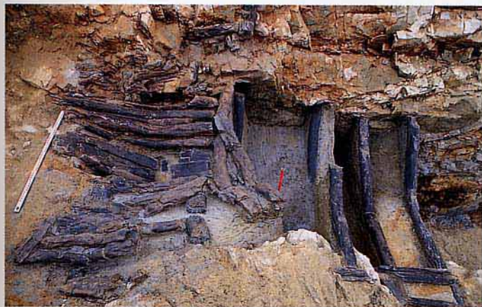
Fig. 42 - Plate-forme de travail faite de planches et placée en haut d'un défilage à la mine de La Fagassière (Château-Chervix, Haute-Vienne).
