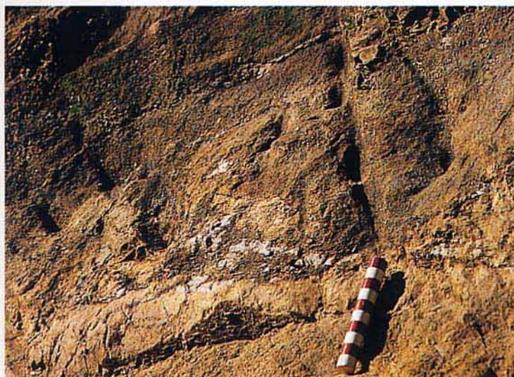
Fig. 34 - Traces de coups de pointerolle laissées dans le front de taille d'un gradin à la mine de La Fagassière (Château-Chervix, Haute-Vienne).
